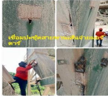
ตรวจสอบหน้างานเชื่อมปะทุ ทาสายพานเส้นจ่าย SMC
