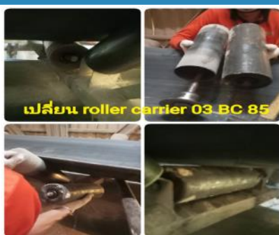
ตรวจสอบหน้างานเปลี่ยน ลูกกลิ้ง Roller carrier 03BC85
