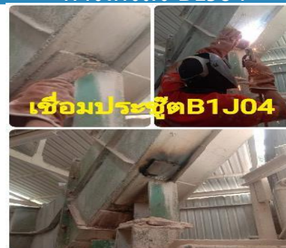
ตรวจสอบหน้างานเชื่อมปะทุทขา กางเกงลง B1J04
