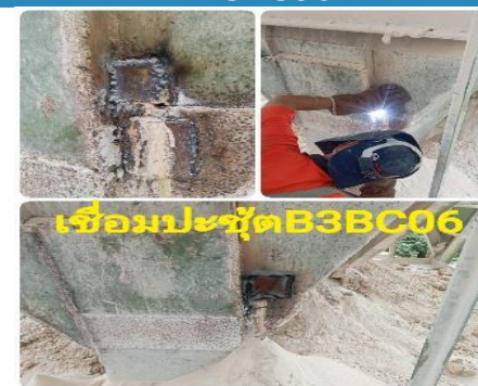
ตรวจสอบหน้างานเชื่อมปะทุทขา BCBC06
