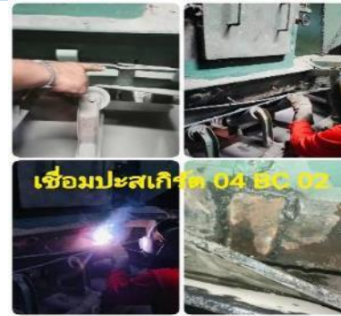
ตรวจสอบหน้างานเชื่อมปะสเกิร์ต 04BC02
